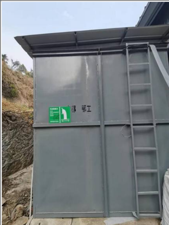
废水排放口标识牌
