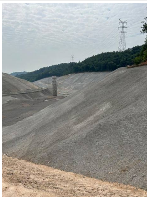
贮灰场堤坝图片
